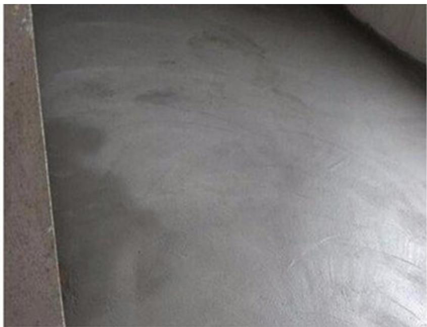
外墙保温抹面砂浆层常见四大问题及原因。三、室内结露。原因：1、窗的节点设计不合理。在节能设计中对窗的设计位置只有一个原则，就是根据保温形式的不同而设置不同的位置。采用外保温时应靠近墙体的外侧。尽量使保温层与窗连接成一个整体以减少保温层与窗体间的保温断点、避免热桥的发生。有的设计人员在设计中忽视了外窗膀传热对耗热指标的影响，对外窗洞口周围的窗膀不采取保温设计处理。这就导致了室内结露；2、冷热桥形成。保温断点设计不合理，导致窗洞周边形成热桥效应，应该改善室内的湿度死角，保持良好的通风条件，从根本上阻断热桥；3、防水设计不合理。在窗户的设计中没有考虑到根部上口的滴水处理，以及窗户下口根部的防水设计处理，水容易从保温层与窗根的连接部位进入保温系统的内部，从而对外保温系统造成危害。
